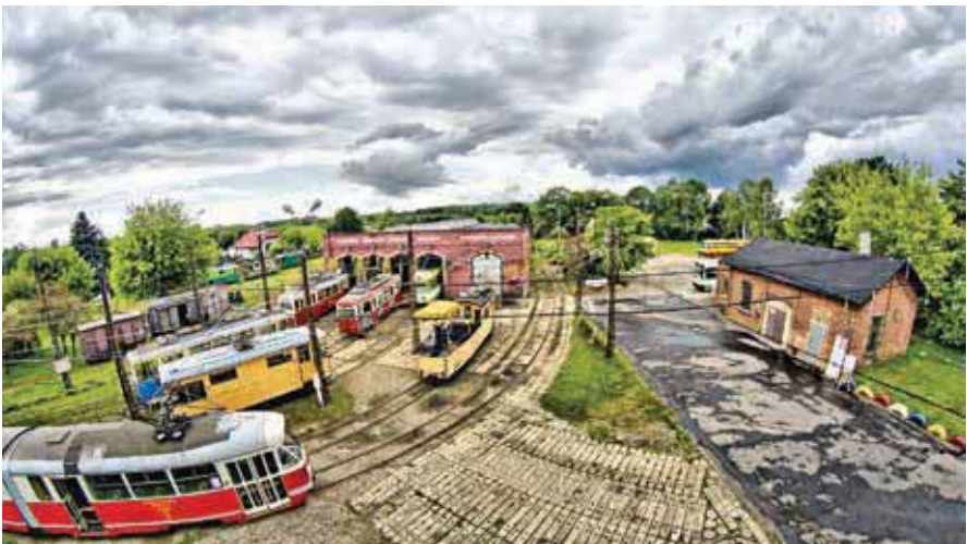
Teren Zajeźdźni Muzealnej Brus widziany z perspektywy kamery szerokokątnej. Od lewej: tramwajowe pole odstawcze (w głębi), hala postojowa, pole autobusowe (w głębi, po prawej) oraz budynek kuźni i hydroforni. Foto: Bartłomiej Rakowski, 14 czerwca 2014 r.
